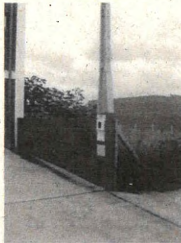
Fotografia 03 -- Vista da entrada de energia.
