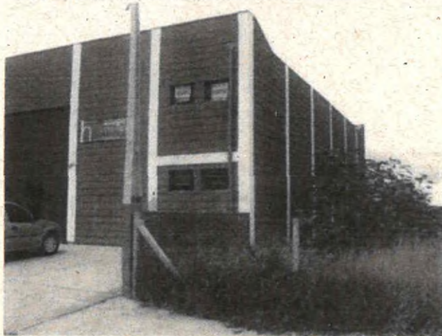
Fotografia 02 – Vista frontal do imóvel avaliado.
