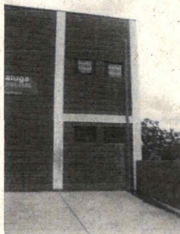
Fotografia 04 -- Vista frontal do imóvel avaliado.
