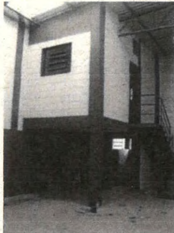
Fotografia 17 – Vista interna do imóvel avaliado, com detalhe para o mezanino.
