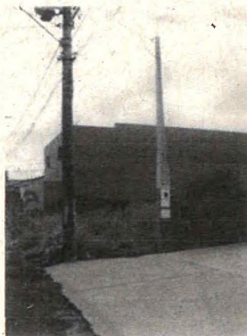
Fotografia 06 – Vista da entrada de energia do imóvel.
