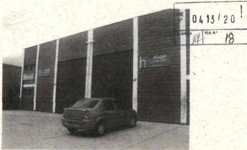
Fotografia 01 – Vista frontal do imóvel avaliado.
