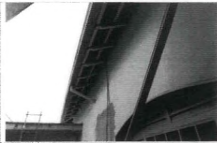
Foto 18 – Calha, condutores e cobertura
