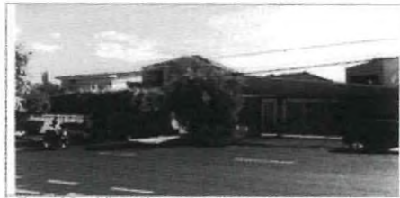
Foto 03 – Vista Frontal do Imóvel Vizinho à Esquerda
