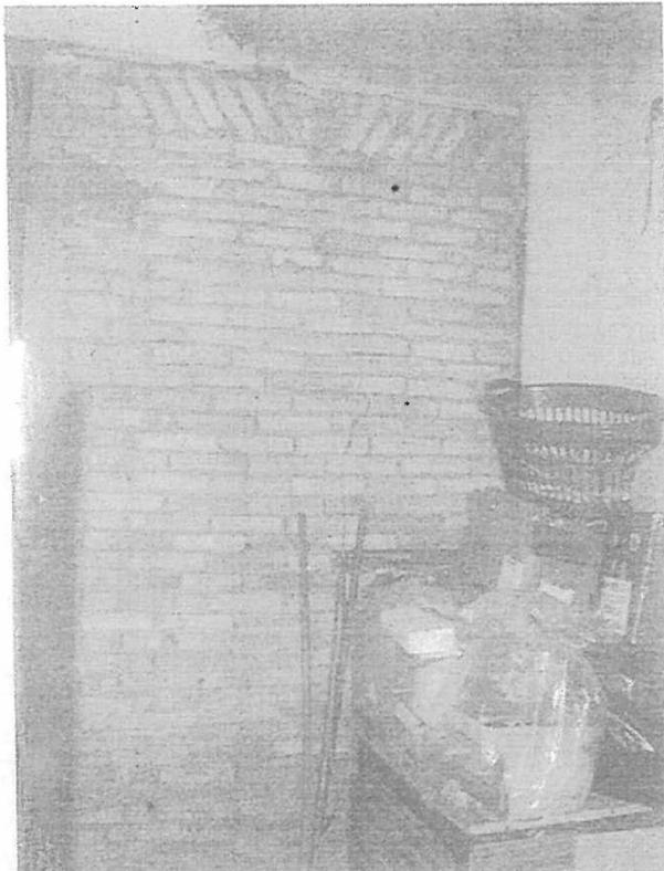
Fotografia 43 – Parede de fechamento inacabada junto à garagem (sem revestimento).
