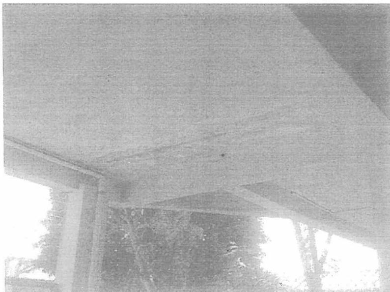
Fotografia 46 – Trecho da laje com pequenas fissuras.
